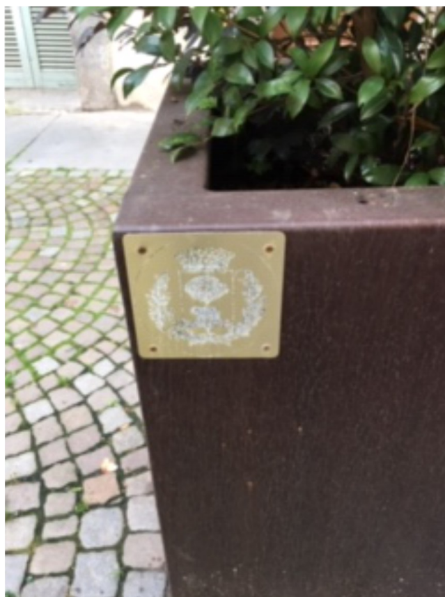
Particolare delle nuove fioriere già arrugginito e corroso
