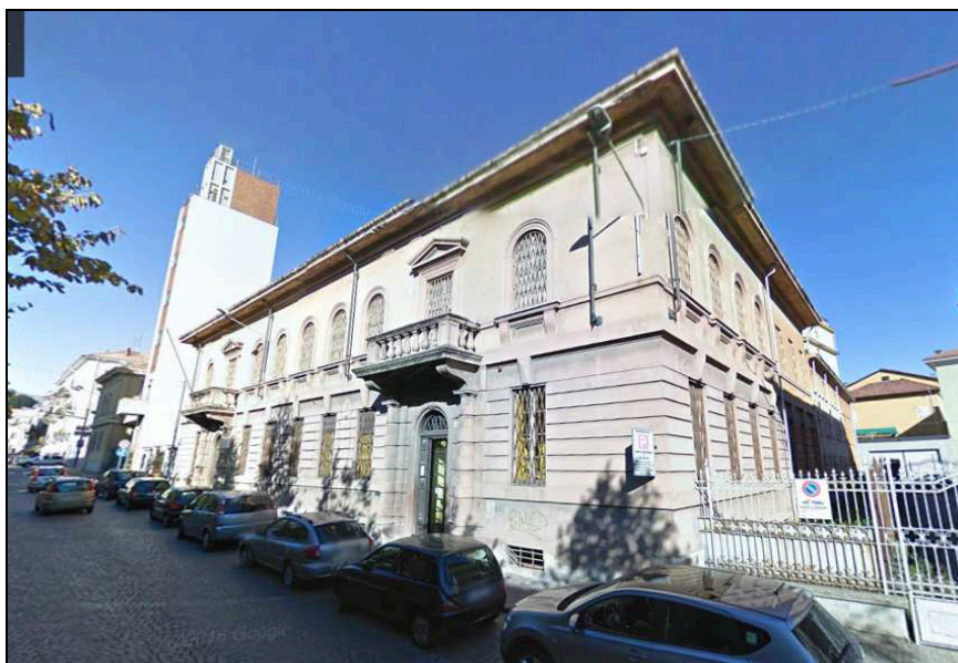
L'edificio della ex Biblioteca civica in via Pietro Micca
