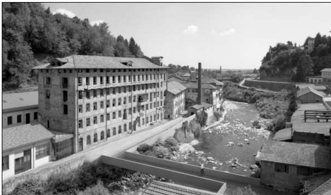
Rendering del progetto vincitore (gruppo Concreto) del Premio Maggia 2015. Al centro il collegamento-passerella sul torrente.
