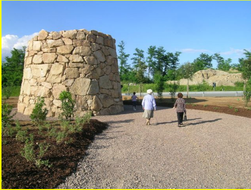
Finto nuraghe realizzato lungo la Strada di Gronda
