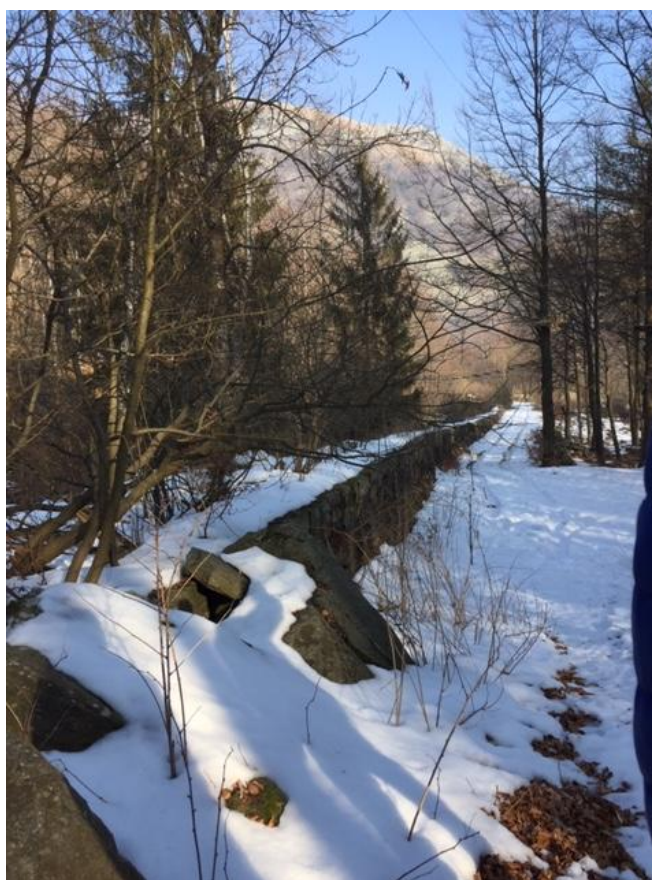
MURO OTTOCENTESCO A CUI SARÀ ADDOSSATO IL MURO IN MASSI SQUADRATI
