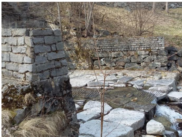
SBOCCO A VALLE DEL PONTE DELLA SP513 - OPERE DI DIFESA ESISTENTI
