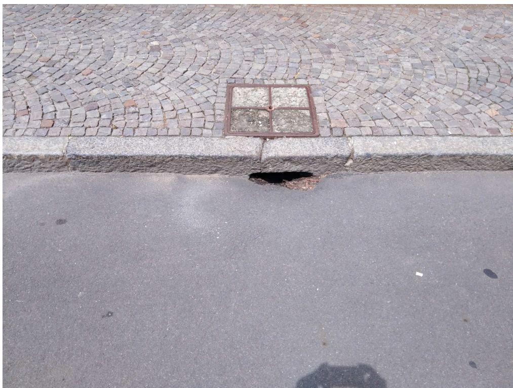
Via Torino: tratto di recente realizzazione, con abbassamento del piano di rotolamento e restituzione della mostra del cordolo del marciapiede a cm 13 di altezza. Si può notare la riapertura della feritoia verticale per la raccolta delle acque di piattaforma.
